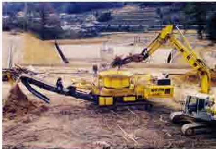
土地造成(伐根、枝葉破碎)
